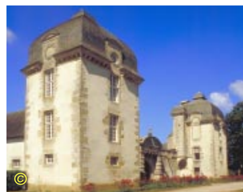
L7-100 - Façade du Château de Beaumanoir, Évran.
