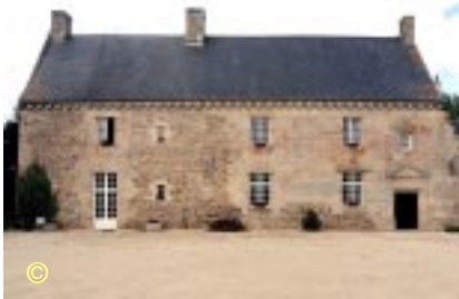
L6-067 Façade du Miroir, à Saint-Méloir-des-Bois.
